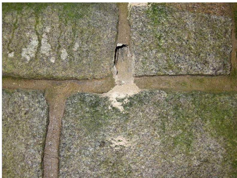
sonda do spáry zdiva - opěra 2
