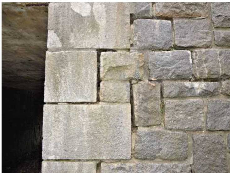
Opěra 2, pravý bok, zatékání, detail volných spar zdiva.
