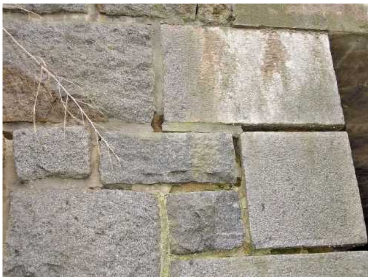
Dtto, detail stavu spárování ve zdivu.
