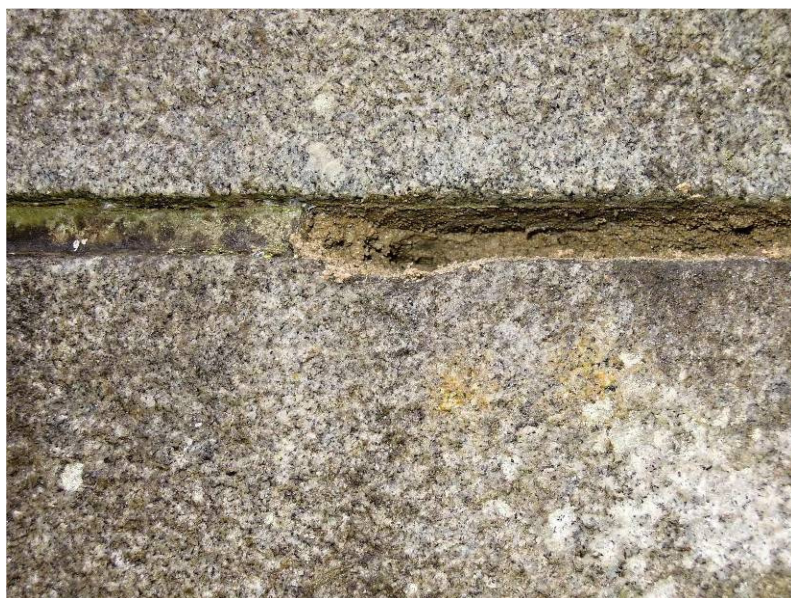
sonda do spáry zdiva - mokrá, rozpadající se malta
