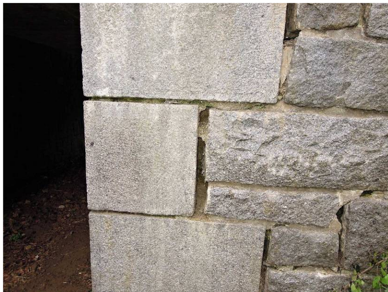
detail narušeného spárování pravého nároží opěry 2
