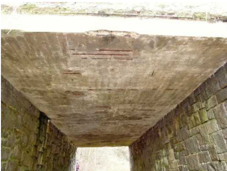
Podhled NK a pohled do mostního otvoru z pravé strany, zatékání po zdivu opěr.
