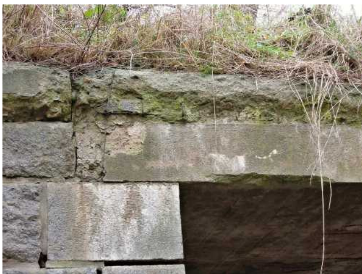
Opěra 1, pravý bok, zatékání dilatační spárou, hloubková degradace betonu boku NK a římsy, volné spáry zdiva opěry.
